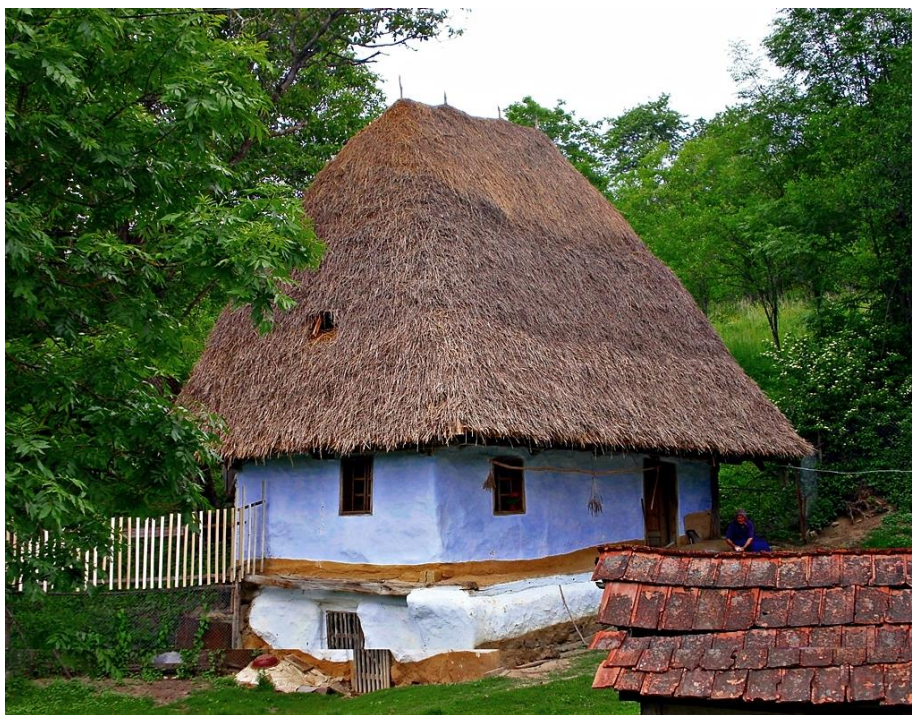
Figură 10 - Casa Morarului Răstoci
